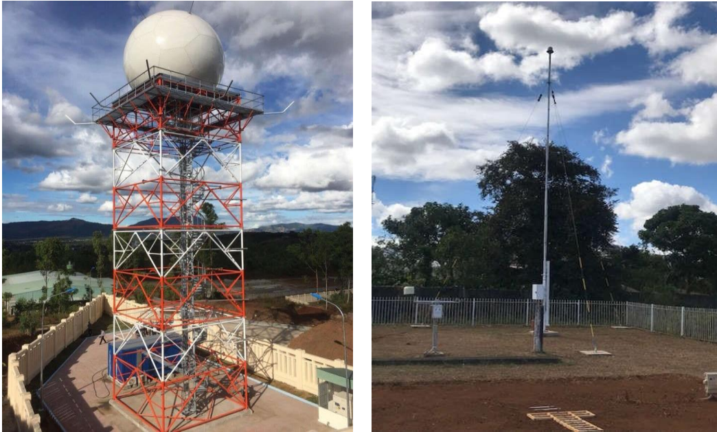
Hình 1. Trạm radar thời tiết và trạm phát hiện sét Pleiku
