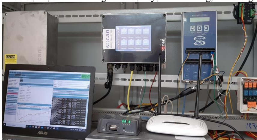
Hình 5. Các thiết bị quan trắc truyền dẫn số liệu về trạm trung tâm
