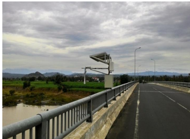
Hình 3. Đầu đo ra đa được lắp trên cầu sông Ba - Phú Yên
