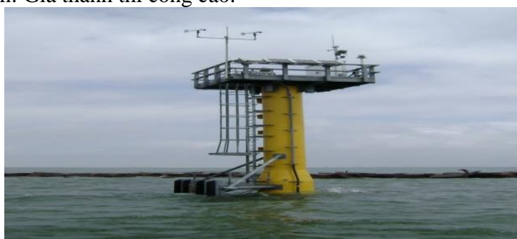
Hình 39. Công trình hải văn bằng bê tông
